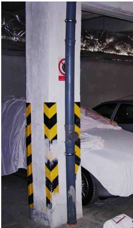
Obr. 37 Sloup v suterénu památkově chráněného objektu z let 1960-61, na první pohled nejsou patrné žádné poruchy.
