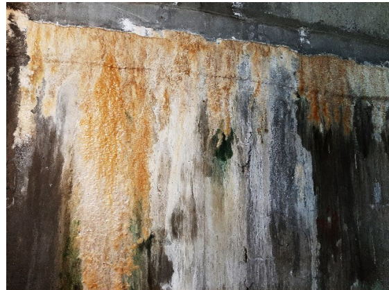
Obr. 12 a 13 Pohled na místa, ve kterých dochází k dlouhodobému pronikání vody, a to především pracovní spárou v monolitickém betonu stěny. Masivní inkrustace uhličitanu vápenatého jsou lokálně zbarveny oxidy železa, což indikuje probíhající korozi výztužných prutů ve hmotě stěny.
